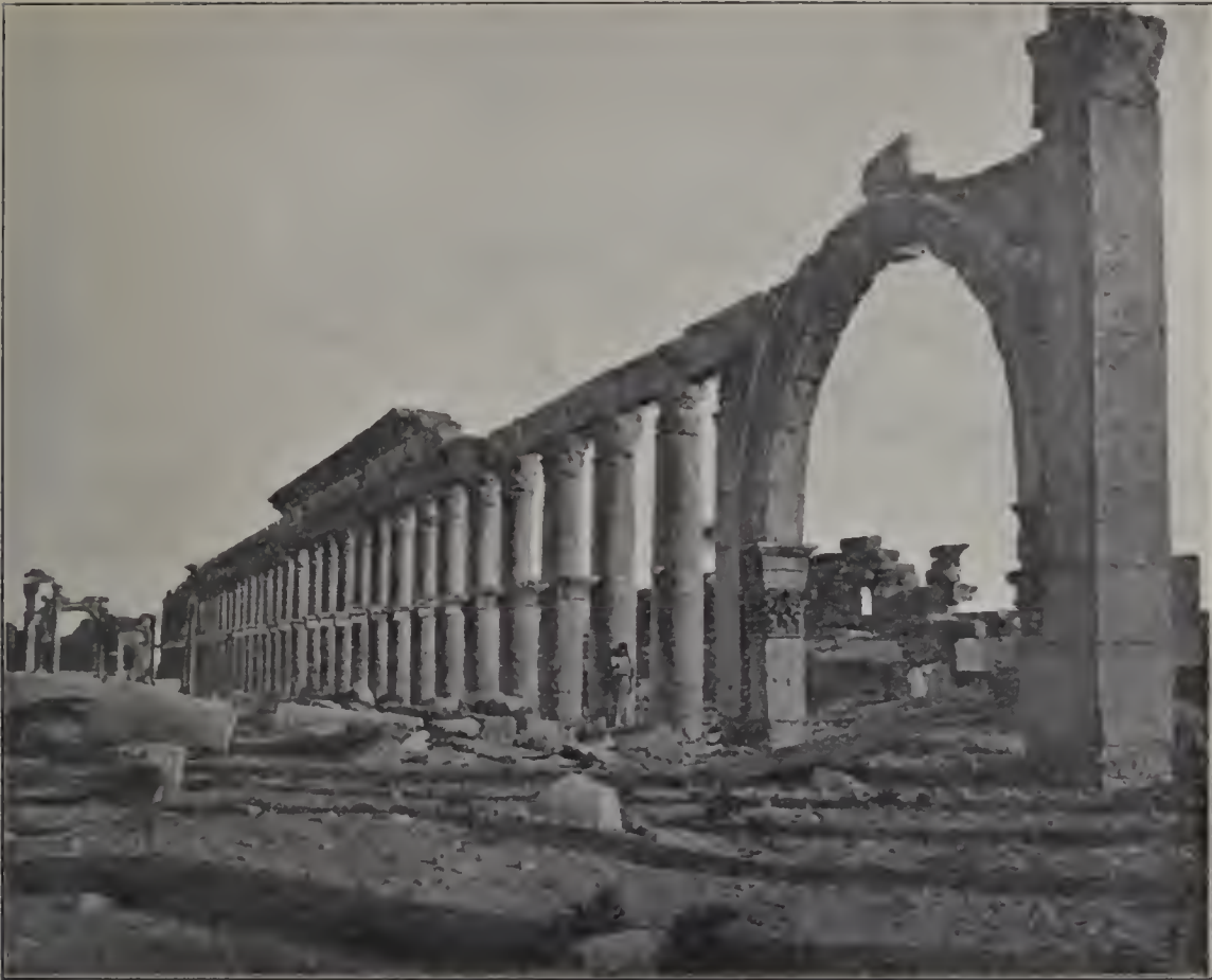
Fig. 229. Palmyra. Reste der großen Hallenstraße.
